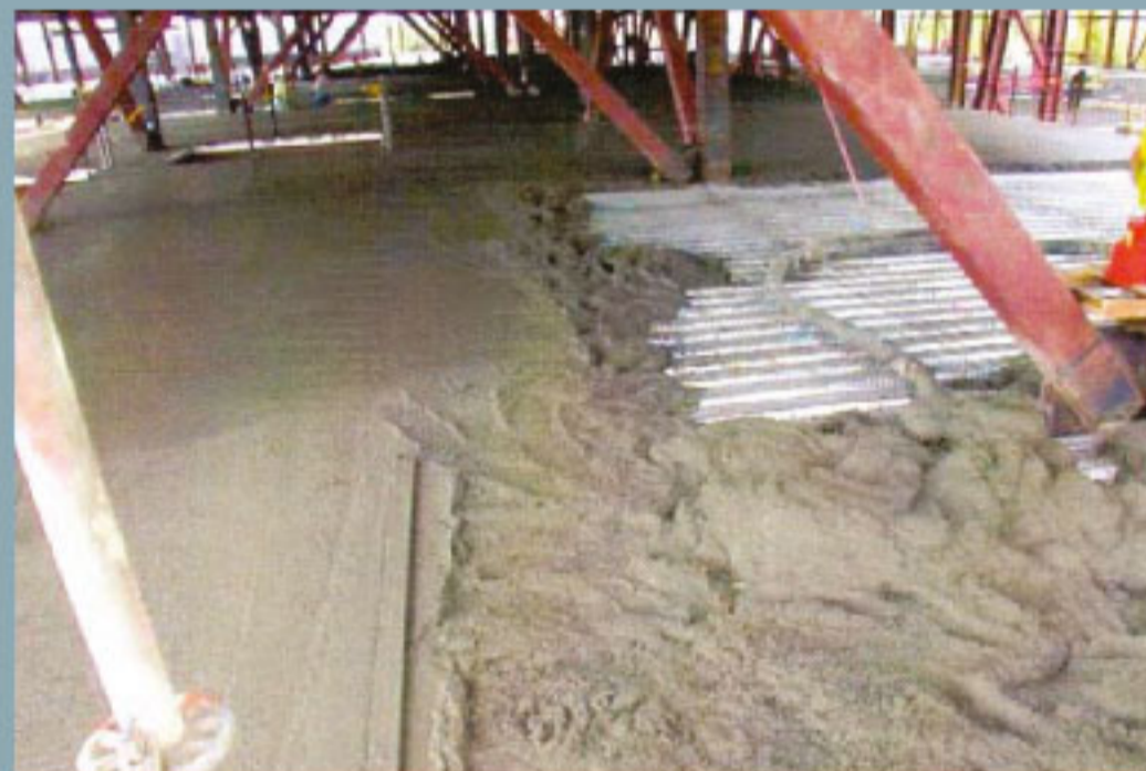
6. ทำการเทคอนกรีต
